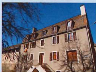
HLM, locaux et cave, quartier la Remise
