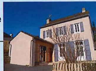
Logement de l'ancienne école de Saint Jean
