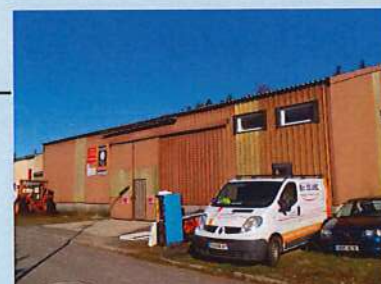
Hangars de la zone artisanale
