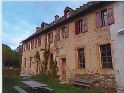
Mairie déléguée, salle communale et appartements de l'ancienne école
