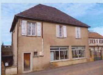
Logement et salle communale de l'ancienne école
