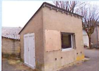
Local et ancienne bascule
