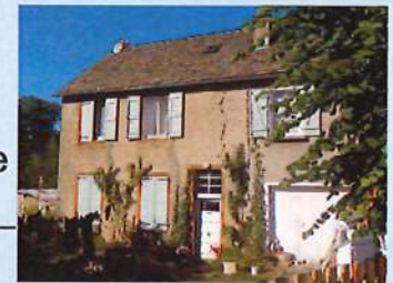
Logements de l'ancienne école du Mazel
