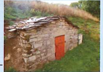
Le puits de Vareilles
