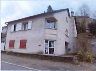
Locaux du centre de loisirs
