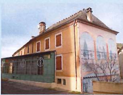
Ancien hotel du commerce et annexe
